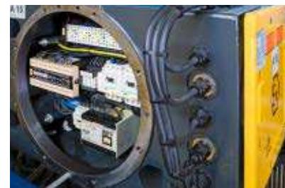
Класс защиты электрошкафа для Зон 1, 2 и 21 на кране и подъемном механизме комбинируется из классов защиты: огнеупорная инкапсуляция «d», повышенная безопасность «e» и защитный корпус «tD».
