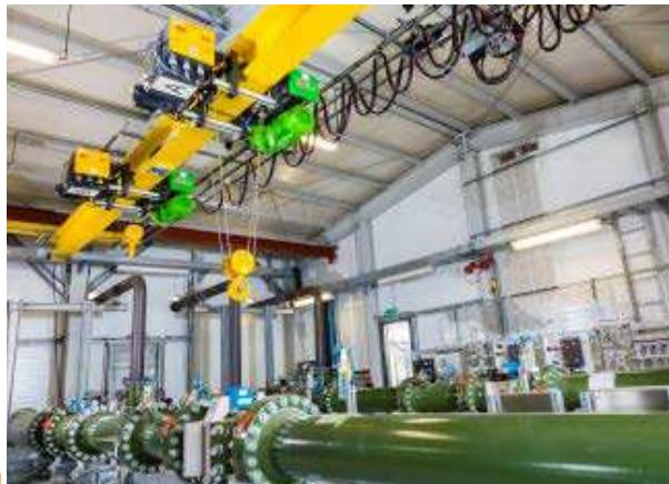
1 Взрывозащищенный тандем-кран с двумя канатными подъемными механизмами SH и дистанционным радиоуправлением используется при строительстве компрессорной станции для газопровода. Канатные тали SH40 ex рассчитаны на подъем грузов весом по 3.200 кг и относительно своей конструкции и безопасности отвечают требованиям европейских директив ATEX.
