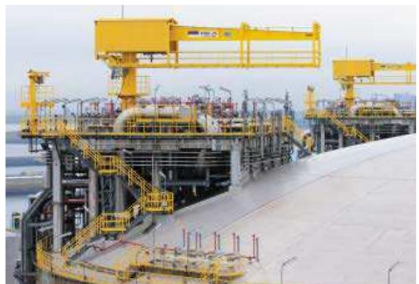
4 Для проведения работ по техническому обслуживанию на насосах танков для сжиженного газа используются специальные подъемные механизмы СПГ. Канатные подъемные механизмы имеют в своем распоряжении два отдельно приводимых в движение канатных барабана грузоподъемностью 2.400 кг каждый. Дополнительный маленький кран с поворотной стрелой оснащенный канатным подъемным механизмом SH ex и используется как вспомогательный кран для транспортировки инструмента и деталей на платформу танка.
