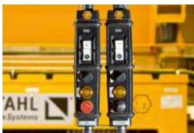
На взрывозащищенных канатных подъемных механизмах для Зоны 1 применяется двухступенчатый пульт управления SWH ex с классом защиты IP 66.
